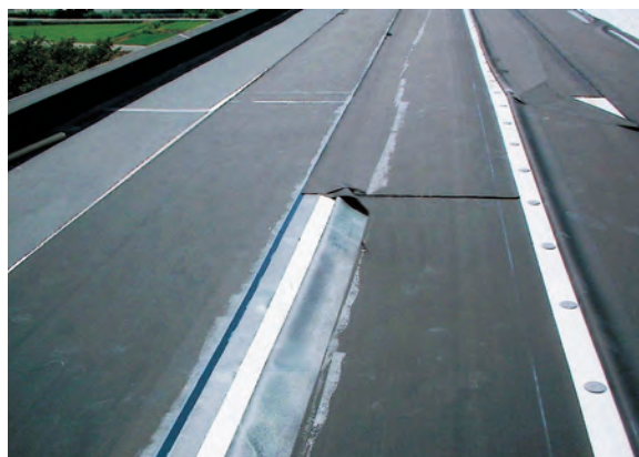
（シートの接合部の張付け）
