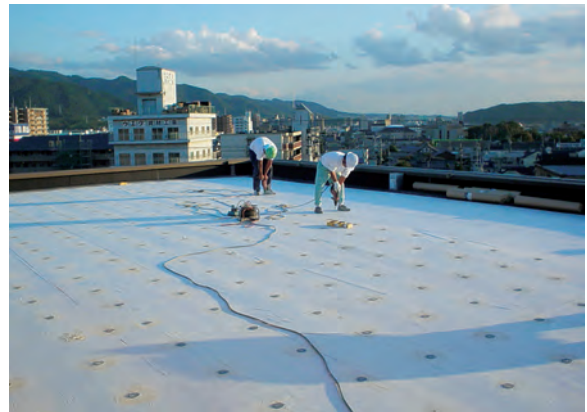
(固定金具の取付け)
