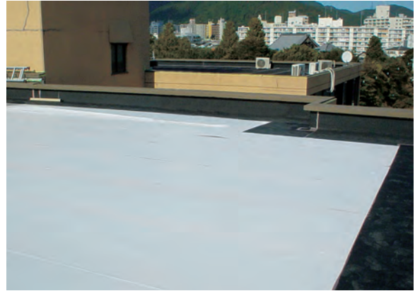
(絶縁シートの敷設)
