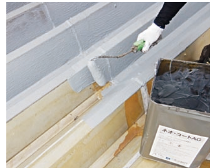
ネオ・コートAG塗布状況
