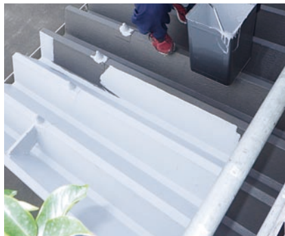
AGトップコートN塗布状況
