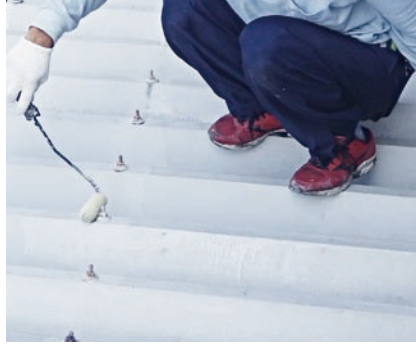
メタルプライマーF塗布状況
