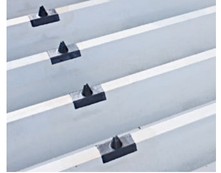
キャップマン取付け状況
