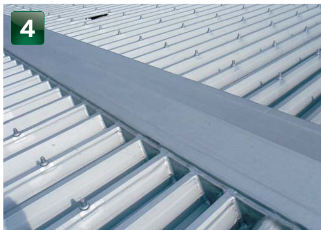
4 仕上塗料の塗布し、完成
