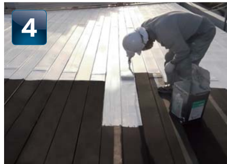
仕上塗料の塗布
