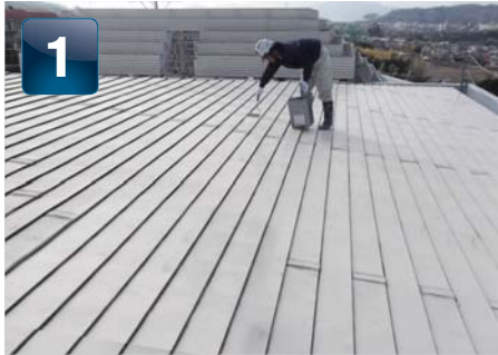
メタルプライマーの塗布(全面塗布)
